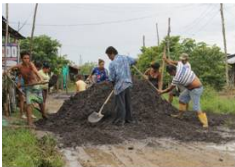
FOTO 2: minga de trabajo comunitario, arreglo de vías de acceso (noviembre de 2012)
