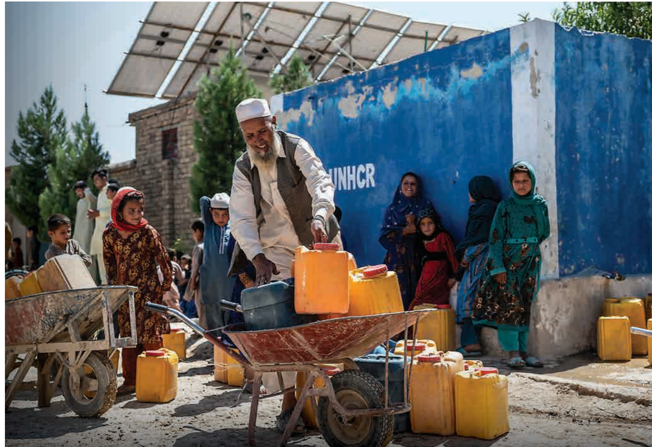
Afgano retornado de Pakistán, Umar Khan, de 65 años, recoge agua de un pozo operado por energía solar cerca de su casa en Tarakhail Daag, cerca de Kabul. Antes de que se construyera el pozo con el apoyo de ACNUR, Umar tenía que caminar mucho para recoger agua de un pozo cerca de la carretera principal o comprarla a un camión cisterna.
